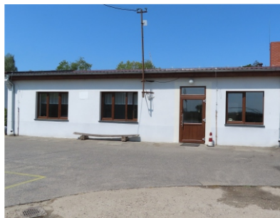
Budynek mechanizacji po remoncie
