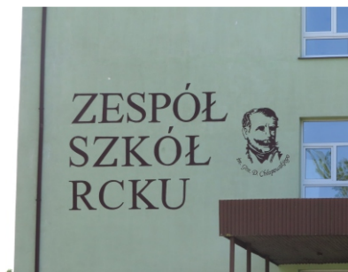
Główny budynek - elewacja zewnętrzna
