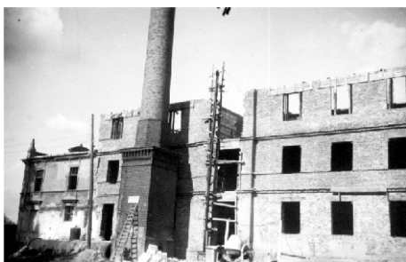
Budowa internatu - 1953r.
