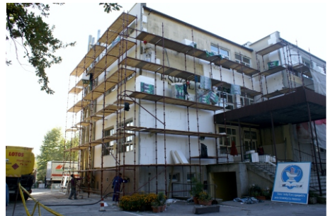
Remont elewacji zewnętrznej głównego budynku szkoły
