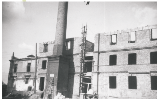
Budowa internatu - 1953 rok
